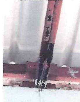
Foto 2: Estructura de metal en deterioro por óxido.
