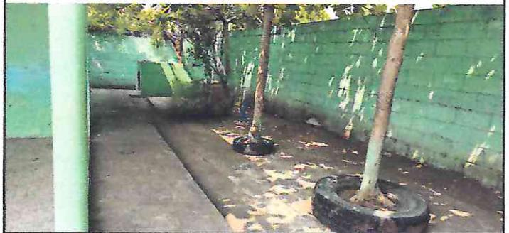
Foto 6: Pintura de muro perimetral deteriorada.
