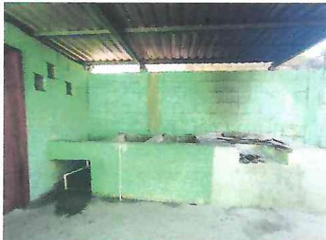
Foto 5: No se cuenta con chimenea y la falta de ello esta dañando la lámina de la cocina.
