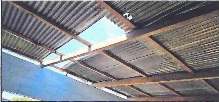
Foto 1: Techo destruido por lluvias con fuertes vientos.
